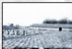
Déchargement des résines dans des plateaux en zinc.
