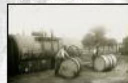
Transportation dans des wagons en gare.
